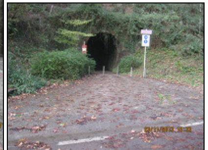
Túnel de Obieta
